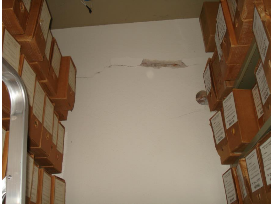
Imagem da sala de Arquivo – Pavimento Térreo
