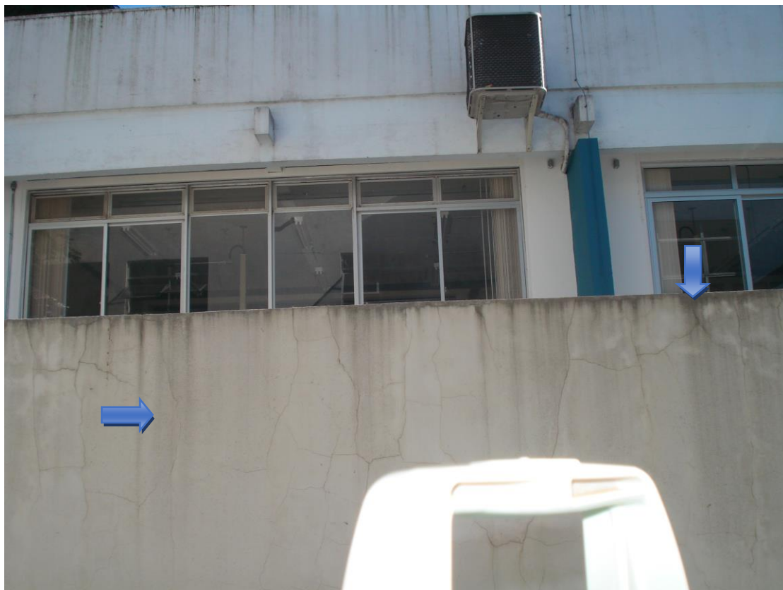
Imagem da Platibanda lado oeste– Pavimento Térreo
