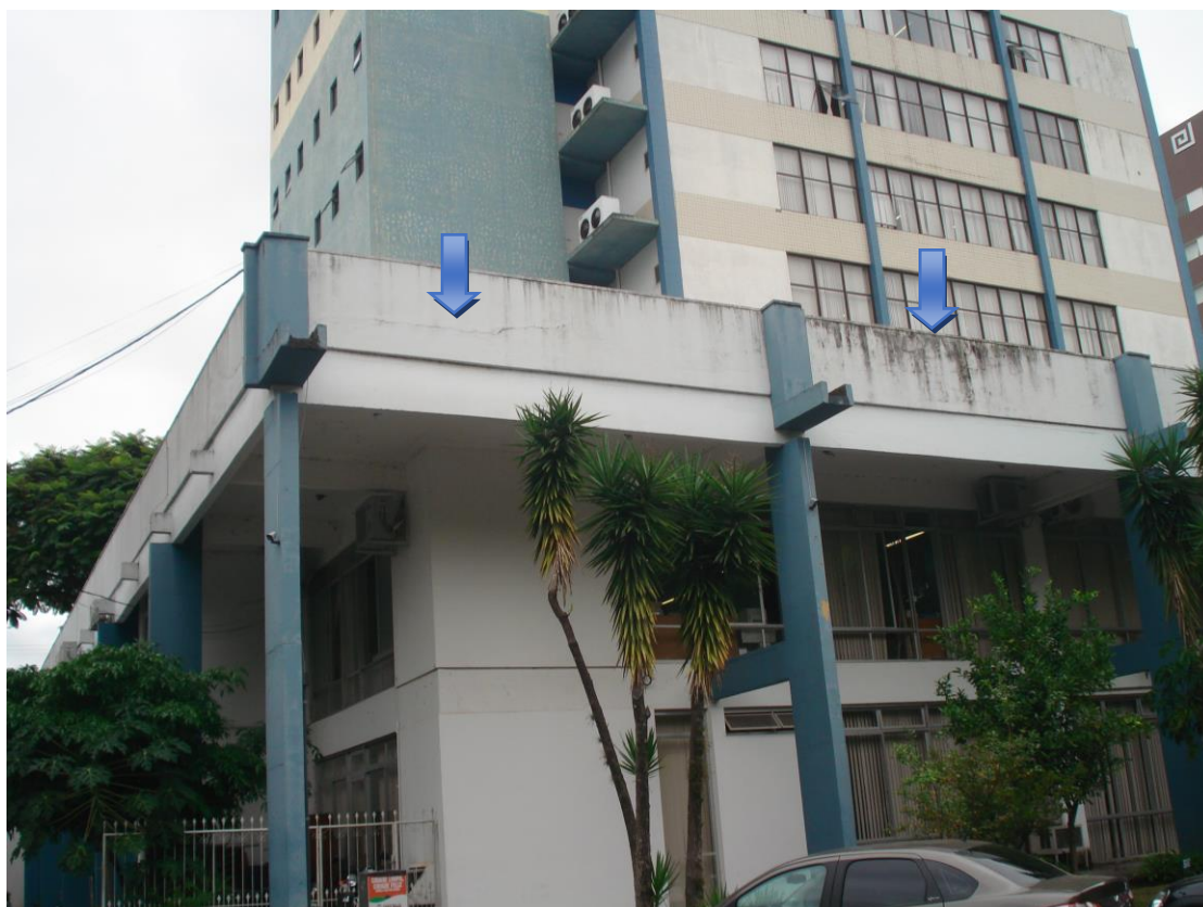
Imagem da Platibanda lado sul-leste – Pavimento Térreo
