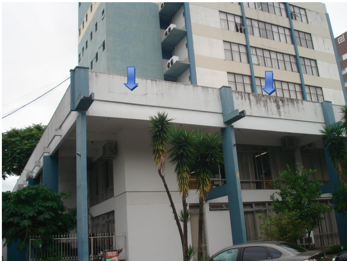
Imagem da Platibanda lado sul-leste – Pavimento Térreo
