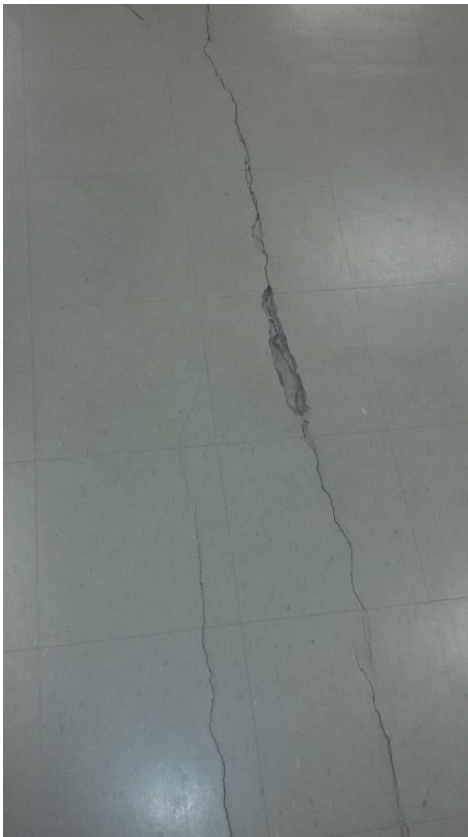
Imagem da Laje Segundo Pavimento
