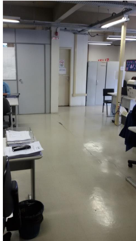
Imagem da Laje Segundo Pavimento
