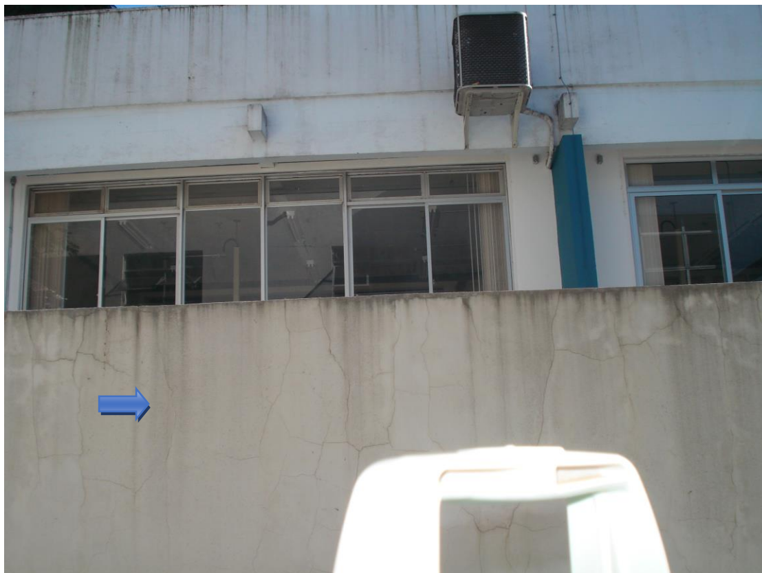
Imagem da Platibanda lado oeste– Pavimento Térreo
