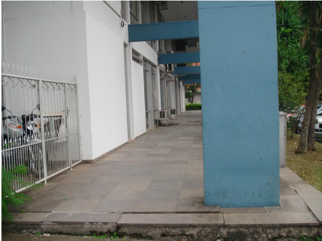
Imagem do piso externo leste e sul – Pavimento Térreo
