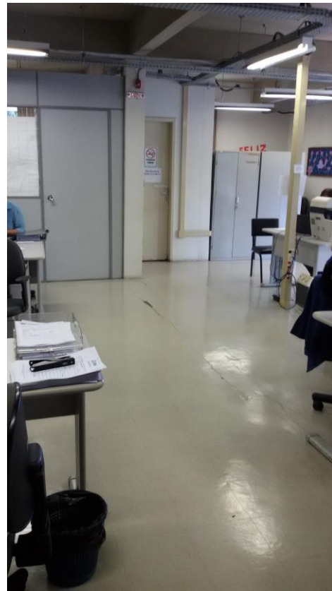
Imagem da Laje Segundo Pavimento
